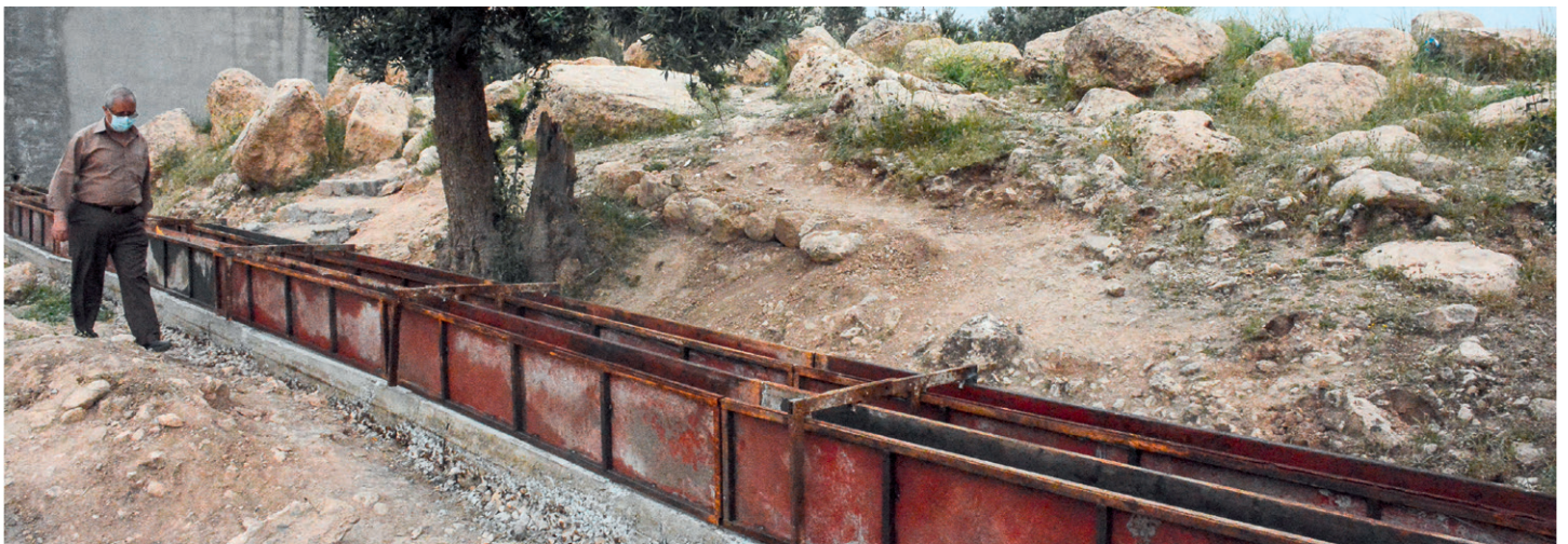
Les nouvelles canalisations mises en place
